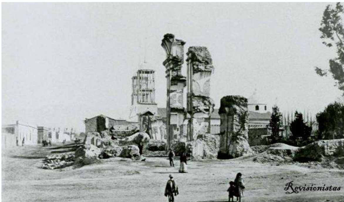
Ruinas de la Iglesia de San Francisco, destruida por el terremoto de 1861 69
